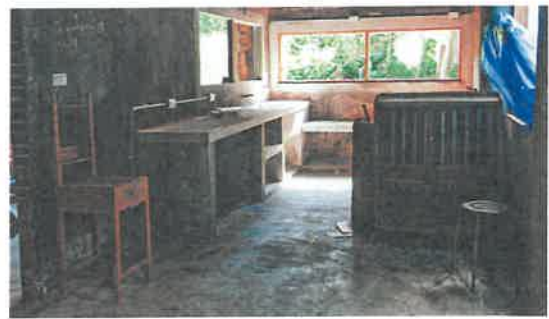
雙口呂文化廚房整修進行中。
